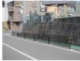
ガードフェンス新設 (三箇 4 丁目)
