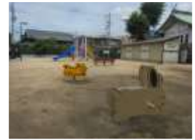
スプリング遊具新設 (三箇 5 丁目)
