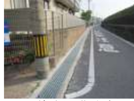
道路側溝改良 (三箇 1 丁目)
