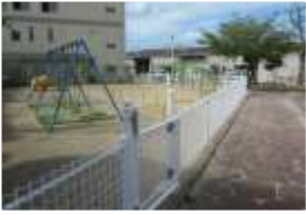
遊具エリアにフェンス
