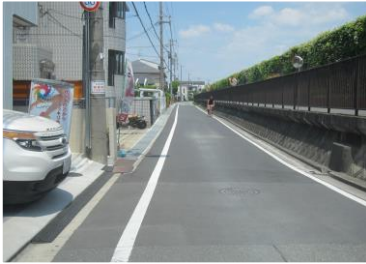
市道住道四の宮線(会所橋付近)
