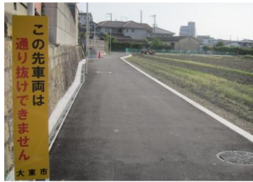
歩道化された中戸水路
