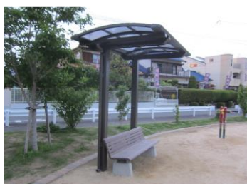
シェルター新設 (三箇4丁目)
