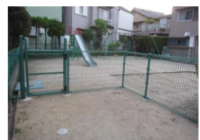
出入口フェンス新設 (三箇3丁目)
