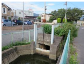
中戸水路流入部水門
