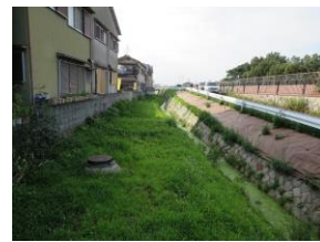
三箇5丁目水路
