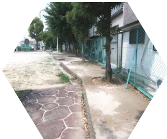
今回施工箇所
